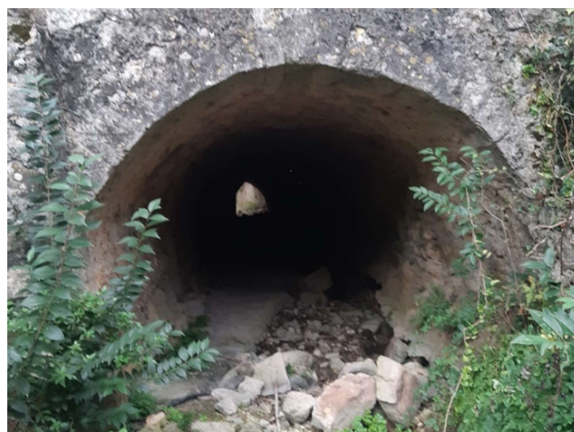
Figure 3 : Galerie souterraine du Verdus
