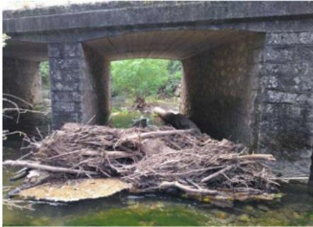
Figure 7 : Exemple de début de formation d'un embâcle sous un pont
