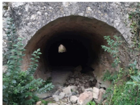
Figure 3 : Galerie souterraine du Verdus
